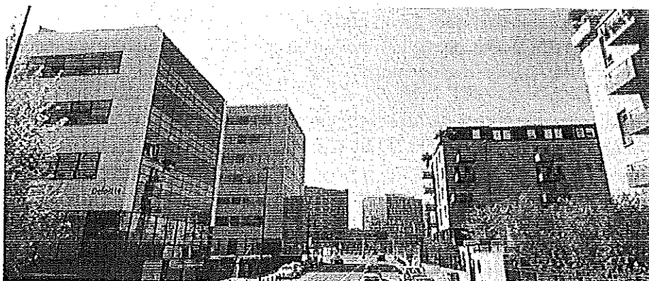
Figure 8: Construction entre l'îlot et Euralille
