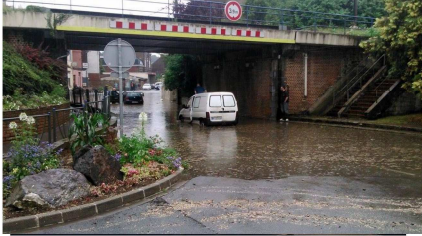
Réseau routier, Rue Jean Jaurès
