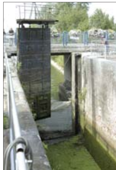
Remplacement des portes d'écluses sur le canal de Roubaix
