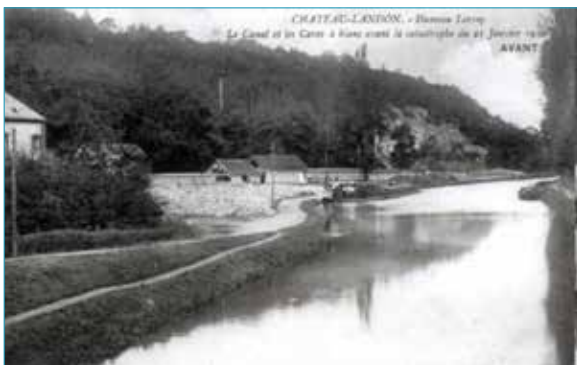
Illustration 1.12 : Site de Lorroy (77) avant l'éboulement de 1910 [carte postale ancienne]
