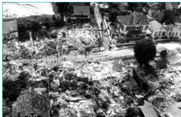
Illustration 1.29 : Vue aérienne partielle du site de Clamart (92) [crédit Ville de Clamart]
