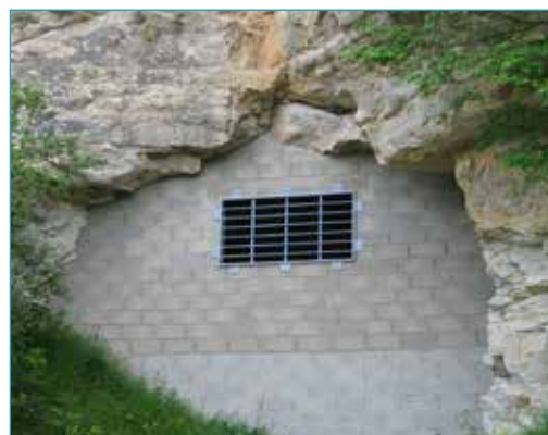
Illustration 3.12 : Accès muré et équipé pour le passage des chiroptères, Côte-d'Or [crédit, 2008]
