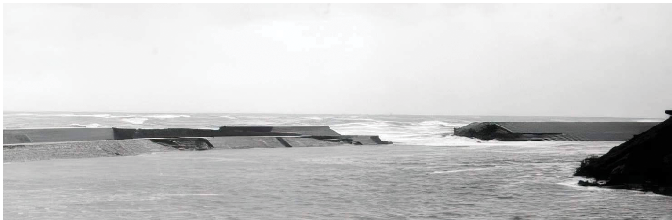
Brèche dans la digue de l'Est ; Source : Archives municipales de Dunkerque
