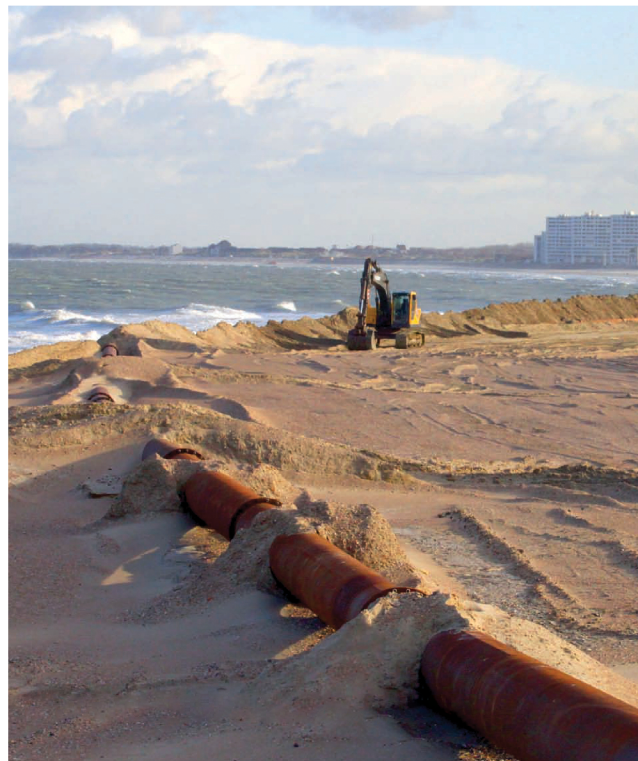
Travaux de confortement, par réensablement, de la digue des Alliés à Dunkerque, Crédits : Communauté Urbaine de Dunkerque
