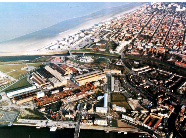
Le site avant démolition: les bâtiments des anciens chantiers navals
