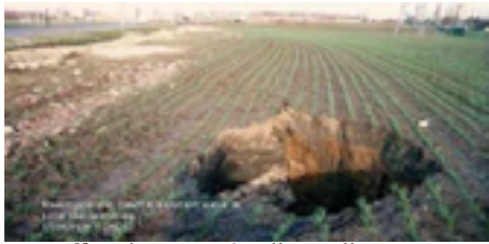
Effondrement à Lille-Hellemmes (source SDIS)
