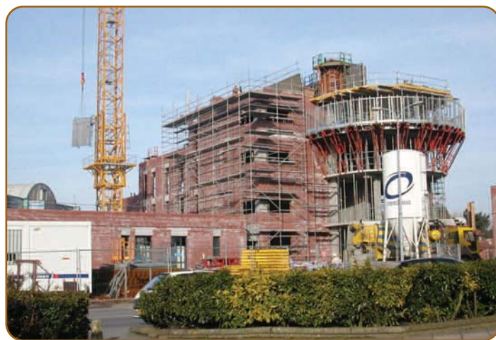
Beffroi en travaux à Douchy - © ANRU
