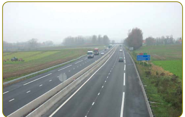
L'A25 après travaux - © DIRN
