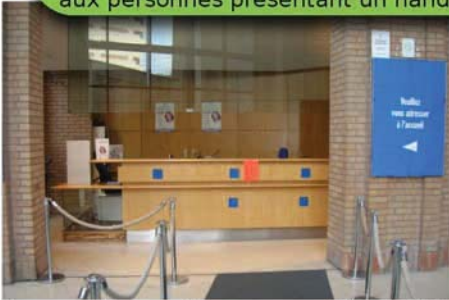
Banque d'accueil non accessible au PMR
