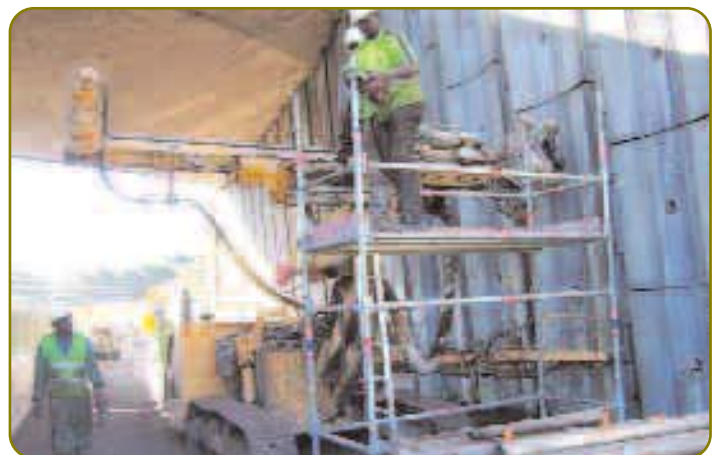
Travaux de renforcement des murs de soutènement de la courbe de Babylone - © DIRN
