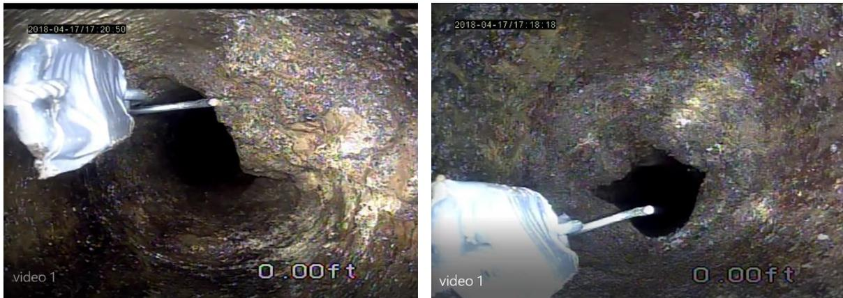
Figure 17 : Exemples de restrictions identifiées dans un sondage
