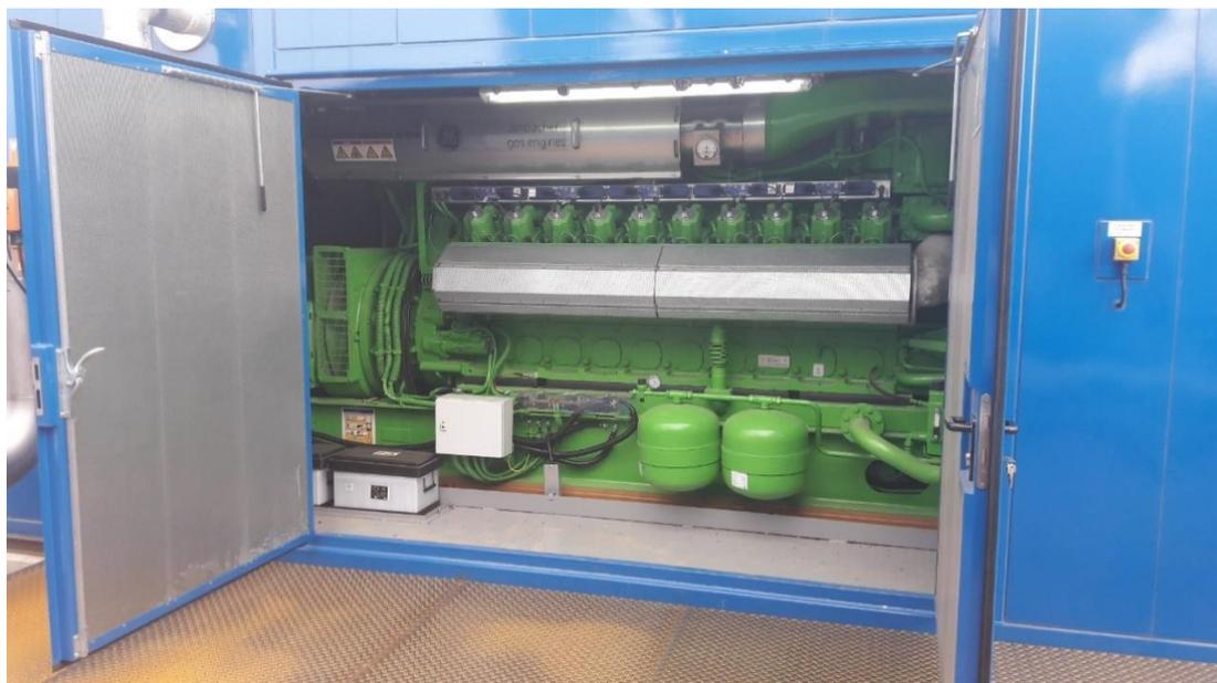
Figure 2 : Vue de l'intérieur du compartiment moteur du module de production d'électricité
